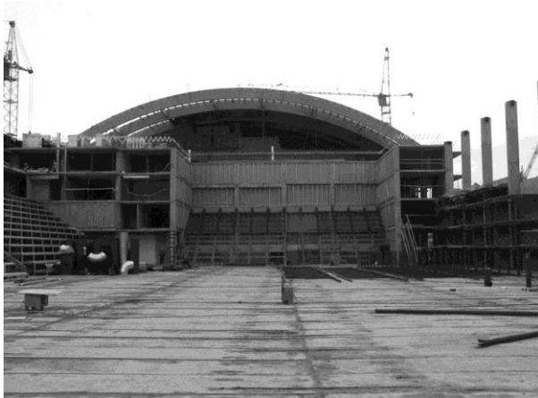
Железобетонные колонны каркаса и кледеревянные арки пролетом 48 м
