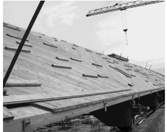
Конструкция деревянного покрытия
