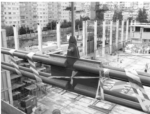
Стальная затяжка из 4 стержней и подвес
