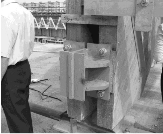
Конструкция опорного узла
