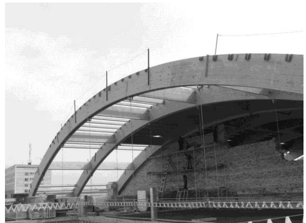
Внешний вид кледеревянных арок покрытия, балок связи и прогонов
