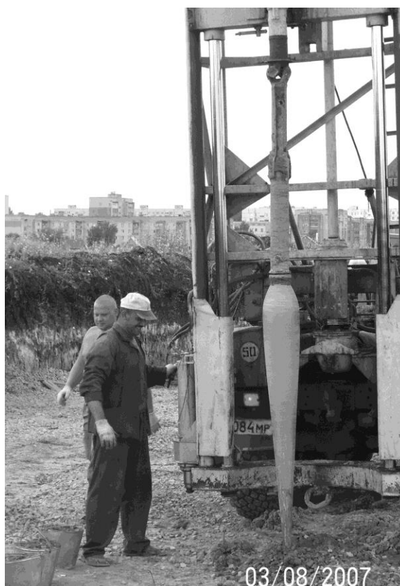
Рис. 2. Пример устройства основания из свай в раскатанных скважинах
