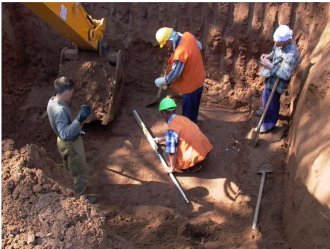
Рис. 9. Подготовка дна выработки перед установкой штампа
