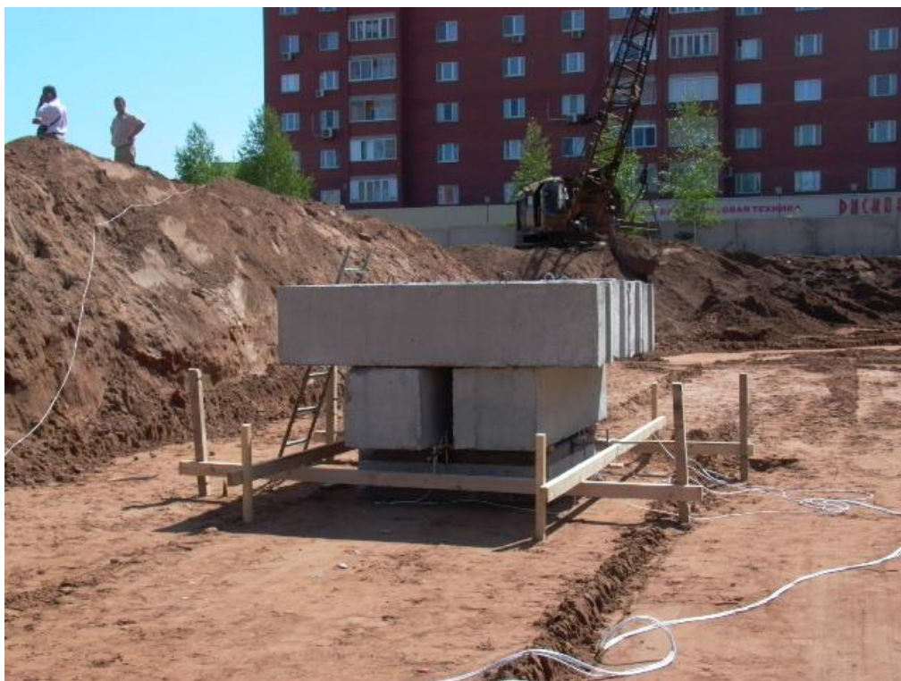
Рис. 6. Нагружение штампа весом фундаментных блоков. Штамп номер 1
